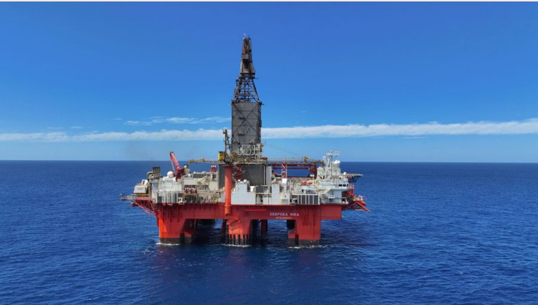
Deepsea Mira semi-submersible rig.
